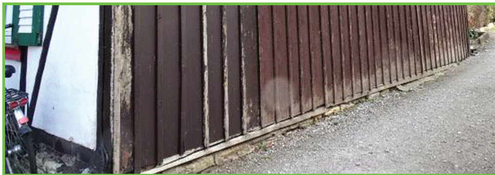
Die Pfarrhausseite vor der Renovierung
