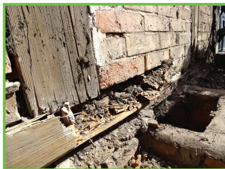
Hier sieht man wie zum Teil "pulverisiert" die Grundbalken sind
