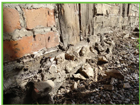
Hier sieht man wie zum Teil "pulverisiert" die Grundbalken sind
