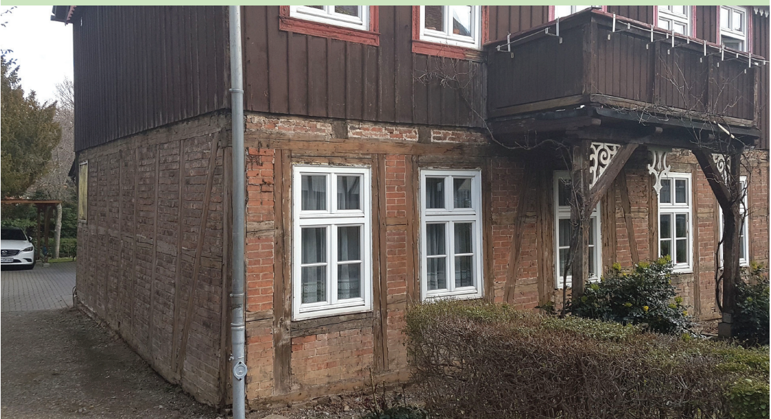
Foto Gemeinde Wernigerode, Pfarrhaus nach der Teilsanierung
