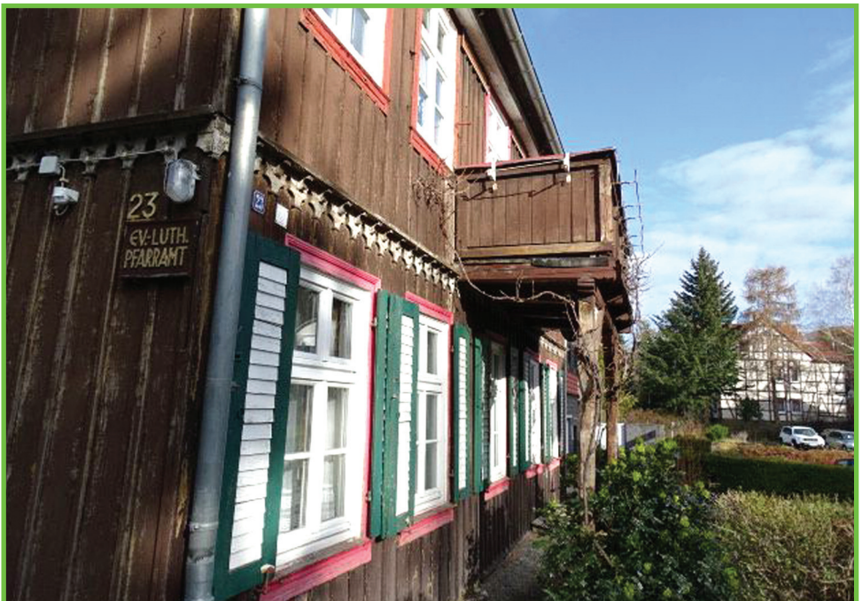
Pfarrhaus in Wernigerode Ansicht vor der Sanierung
