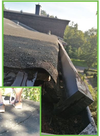
Fotos: Beispiele der Schäden der Dachpappe am Dach.
