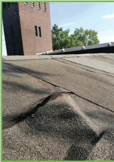
Fotos: Beispiele der Schäden der Dachpappe am Dach.
