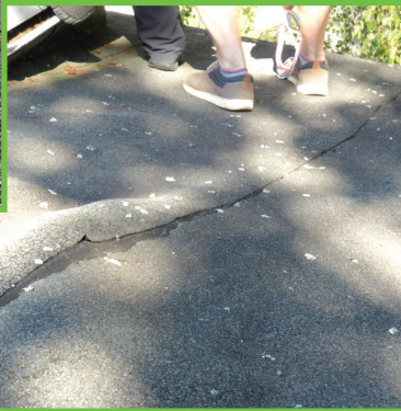
Fotos: Beispiele der Schäden der Dachpappe am Dach.
